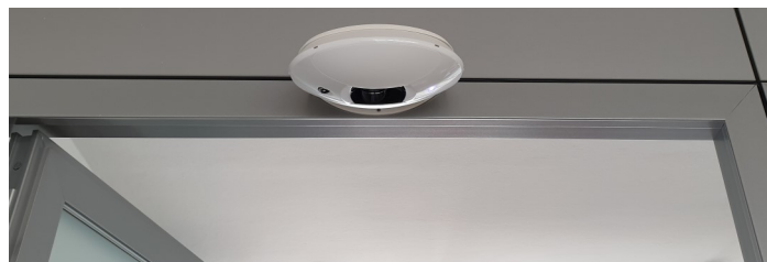
SENSORE LSR-PEOPLE con tecnologia laser scanner per il conteggio delle persone
